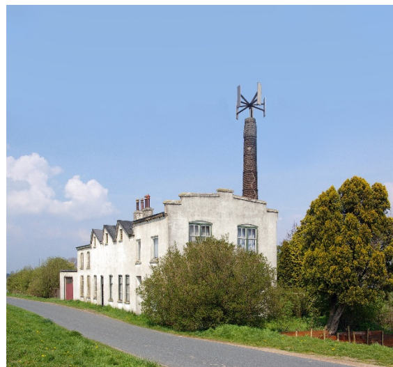
Links een reeks windmolens van het propeller-type met windvaan of staart. Ze staan aan de zoom van een weiland. Het zijn flinke exemplaren (rotordiameter 12m. vermogen ca. 15 kW; jaaropbrengst op deze plek ca. 20.000 kWh/jr per molen). Omwille van goede windvang moeten de struiken niet veel hoger worden. Rechts een beeldimpresie van een VAWT, opgesteld op de schoorsteen van een fabriekje. © Huisman Media en © ejn.
